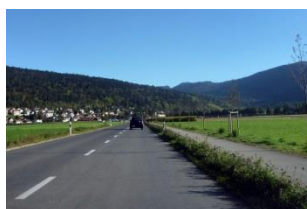
Figure 30 – Site propre MD le long de la route du Seyon au Val-de-Ruz
