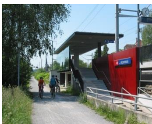
Figure 39 – Chemin d'accès vers une gare régionale (Zoug)
