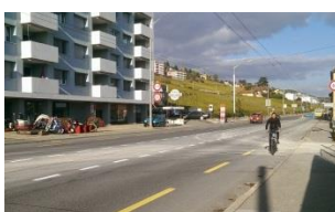
Figure 15 – Bandes cyclables latérales à Monruz (Neuchâtel)
