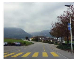
Figure 28 – Bandes cyclables sur la rte de Boudry à Cortailod
